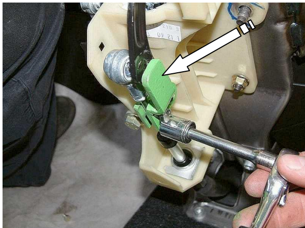
Установить хомут на тягу
