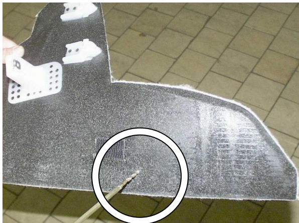
Просверлить отверстие под корпус замка
