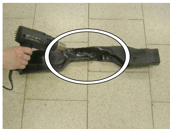
Нагреть феном воздуховод, сформировать выемку под замок
